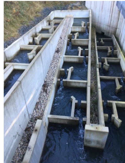
Abbildung 2 enature® Fishpass bei KW Zwatzhof - Obere Forellenregion (Epirhithral)
