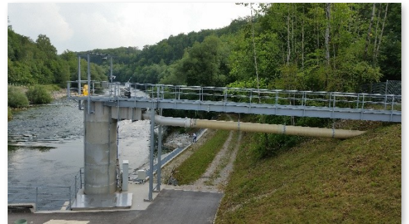
Abbildung 3 Fischliftschleuse Gmunden an der Traun (Höhenunterschied zw. OW und UW 12 m)
